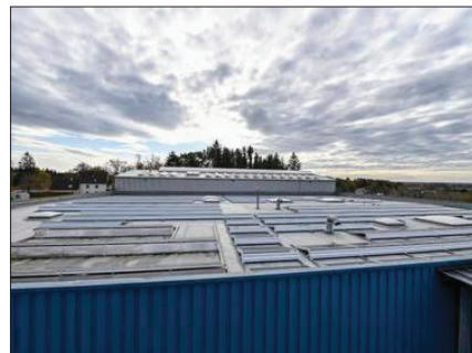
269 Solarpanele wurden auf dem Flachdach angebracht.
